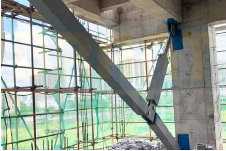
Şekil 3. Sismik damper örneği [11]
