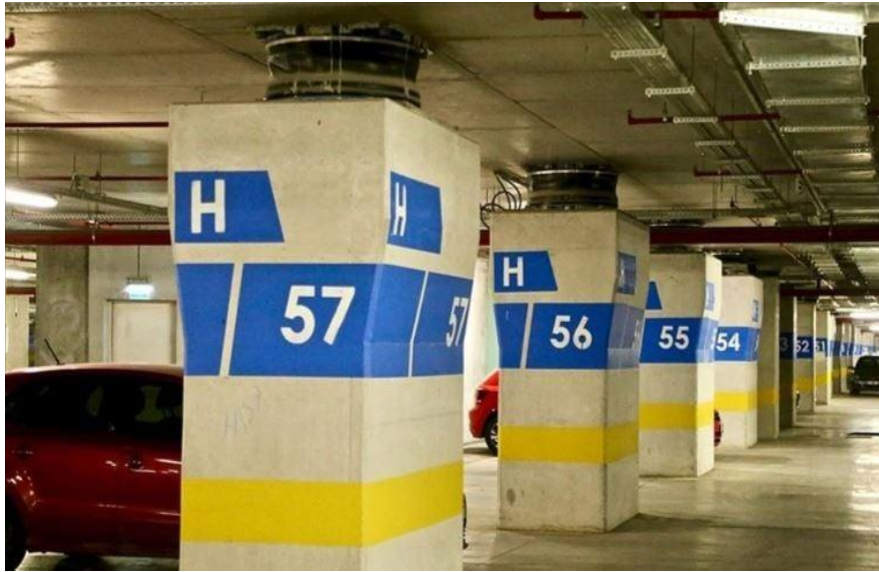
Şekil 1. Deprem izolatörü örneği [9]
